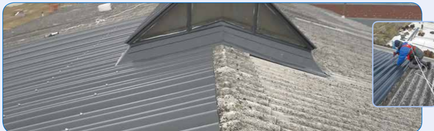
WELLPLATTENSANIERUNG MIT SCANWELLPLATTEN
