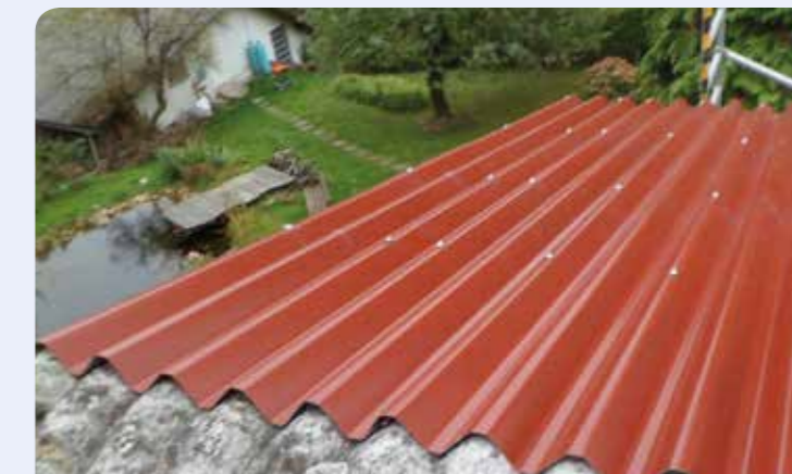
WELLPLATTENSANIERUNG MIT SCANWELLPLATTEN
